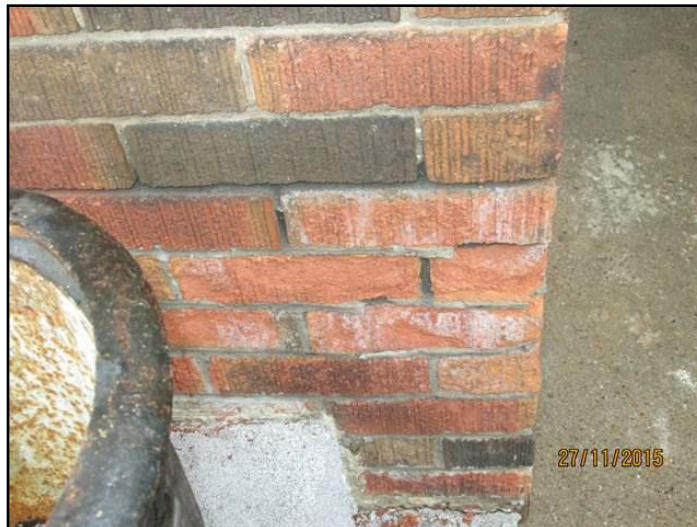
Spalling
