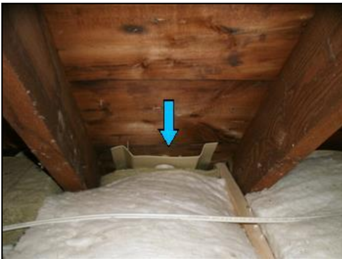
Soffit baffles
