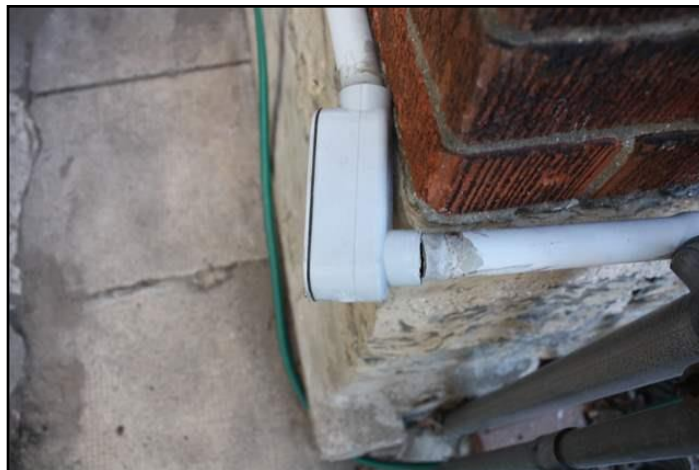
13. Conduit disconnected
