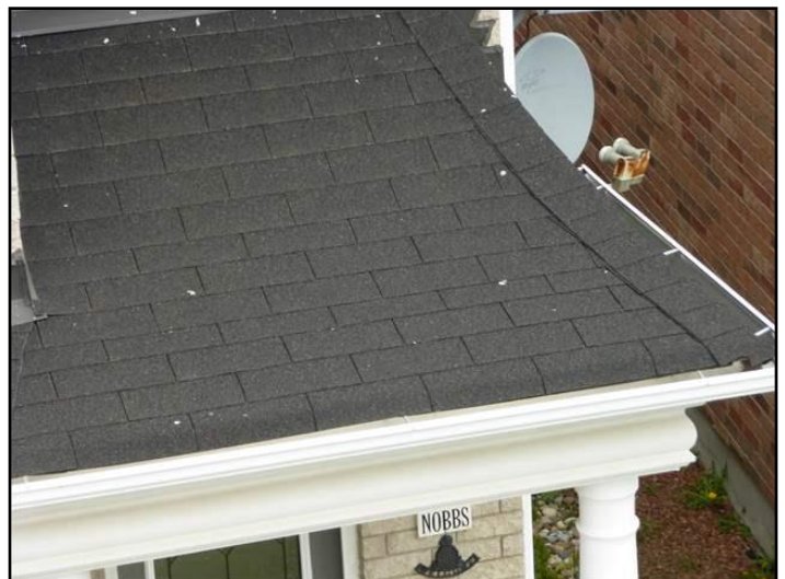
Asphalt shingles - above door
