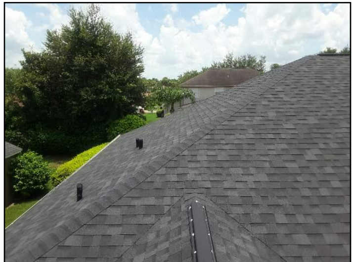
24. Asphalt shingles
