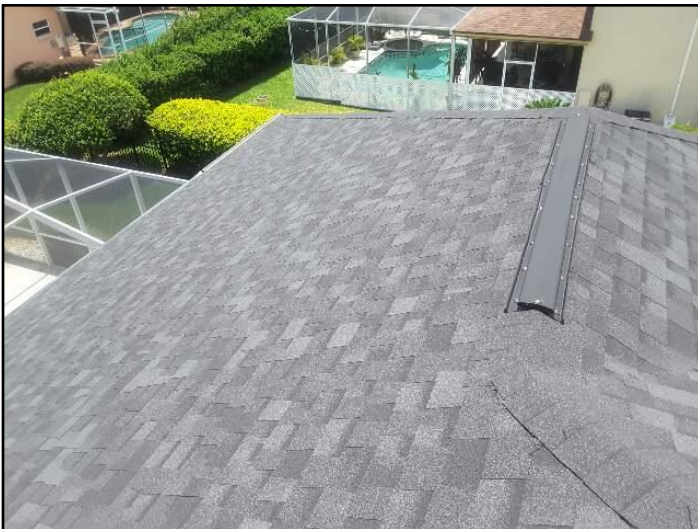
23. Asphalt shingles
