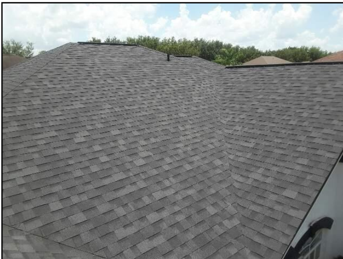
19. Asphalt shingles
