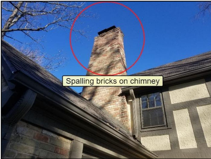
39. Spalling
