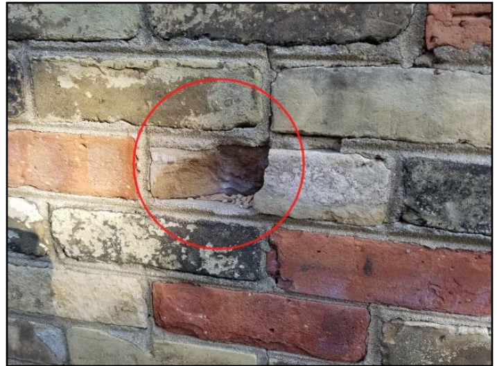
40. Spalling
