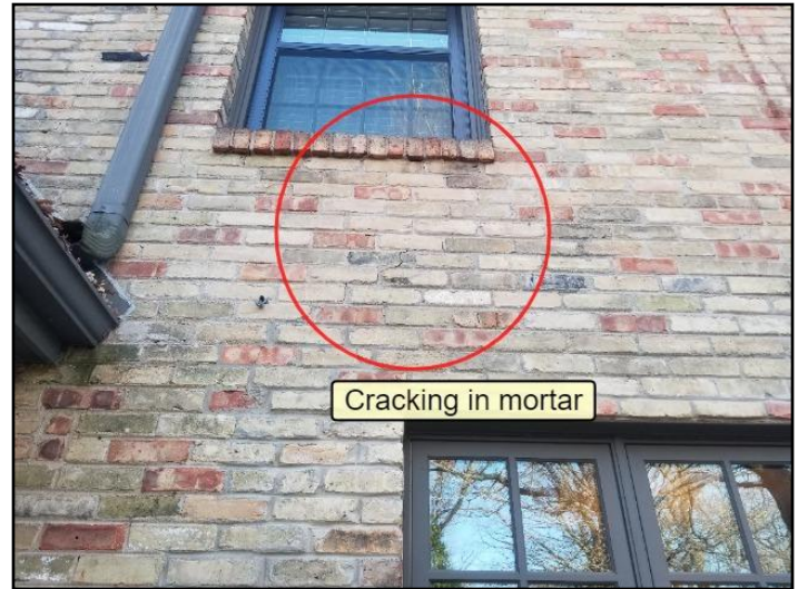
44. Mortar deterioration
