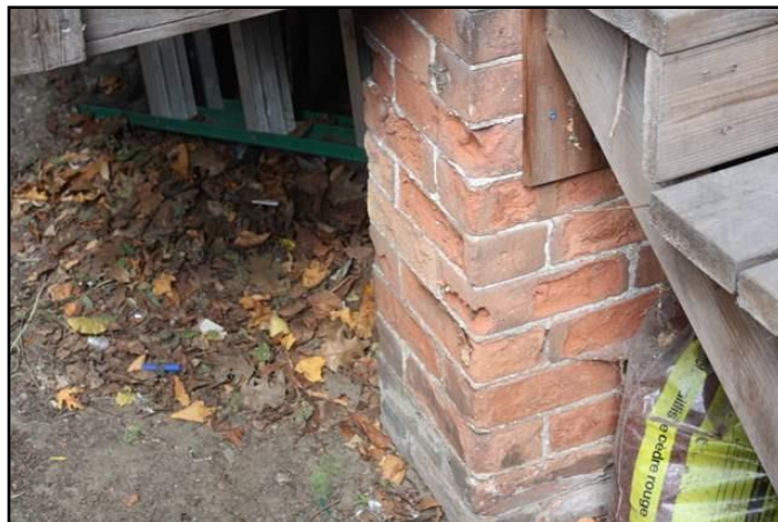
Spalling
