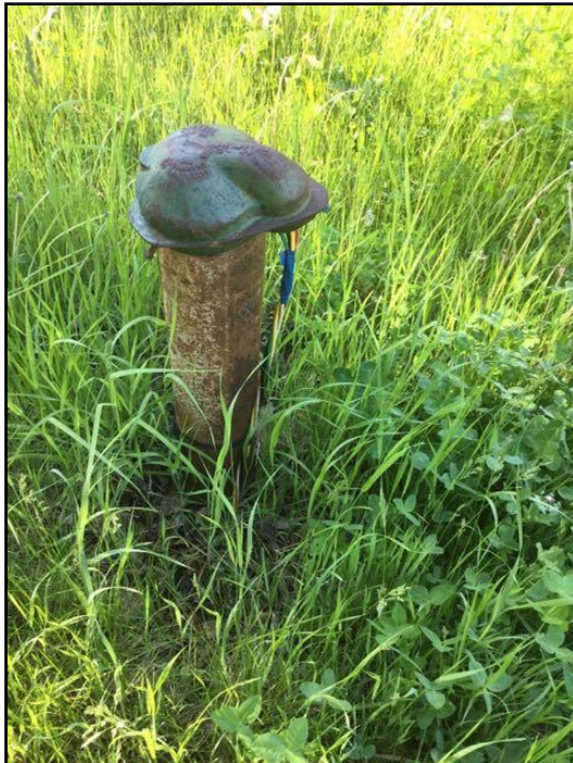
15. Flexible conduit needed
