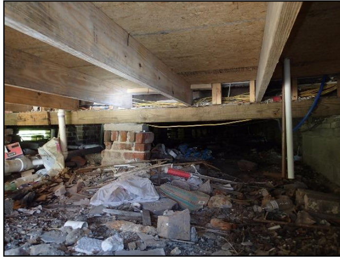
28. Mortar deterioration
