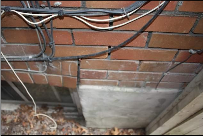
21. Mortar deteriorating
