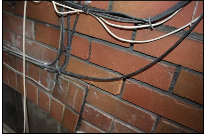
22. Mortar deteriorating
