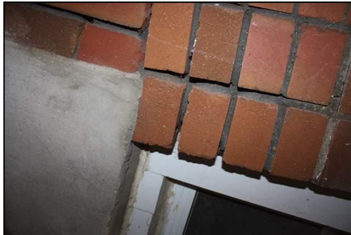
23. Mortar deteriorating
