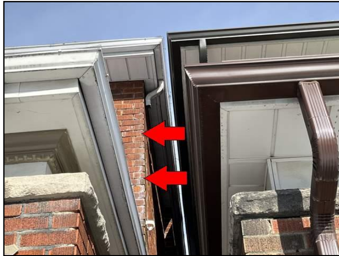
23. Efflorescence
