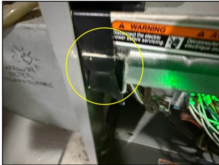
20. Fan cover/access door interlock/safety...
