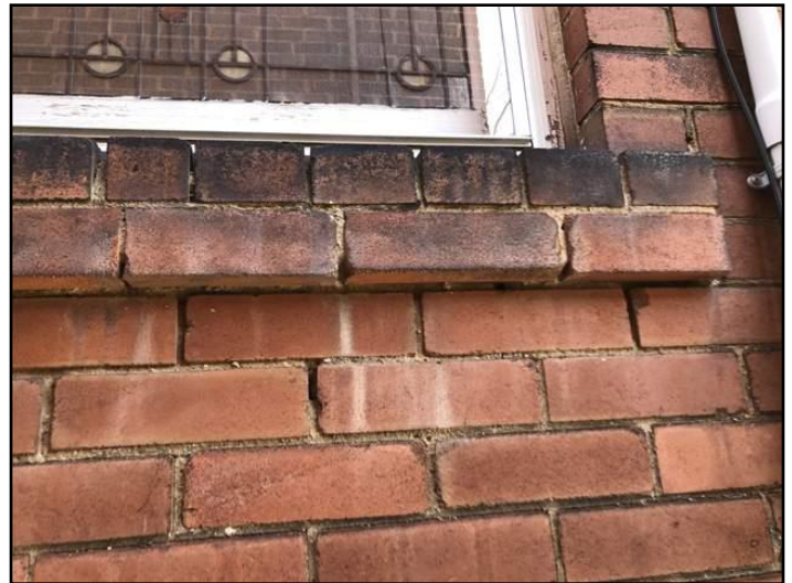
16. Mortar deteriorating
