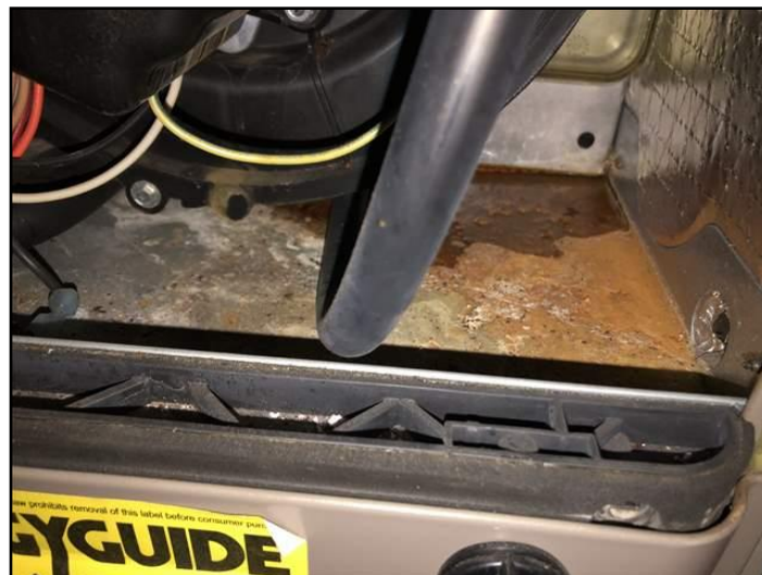
21. Condensate leak
