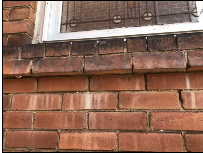
17. Mortar deteriorating
