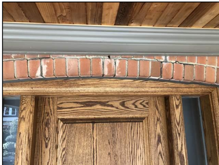
4. Cracks over door
