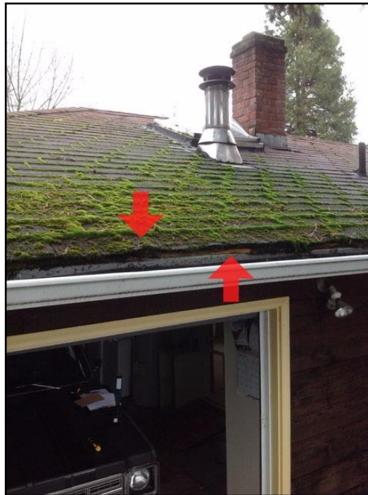
45. Missing drip edge flashing
