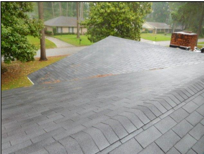
28. Asphalt shingles
