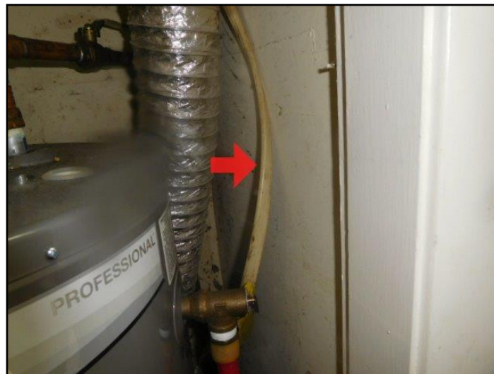
70. Flexible conduit needed
