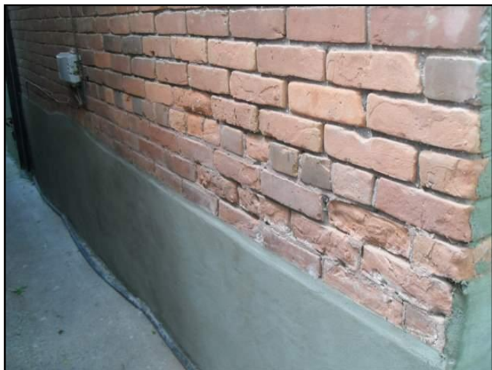
Spalling
