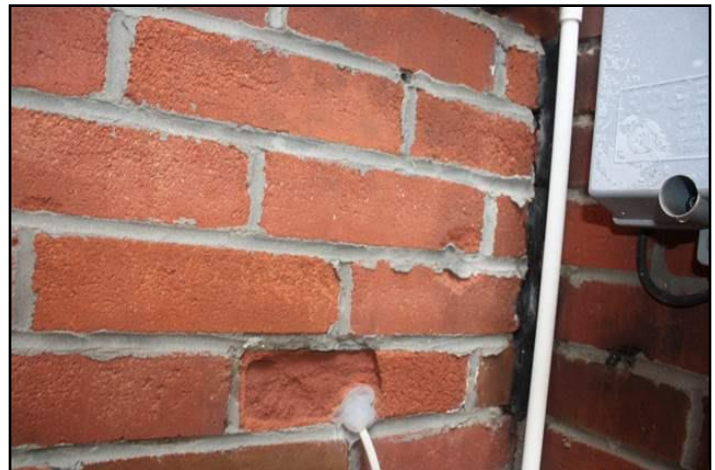
10. Spalling
