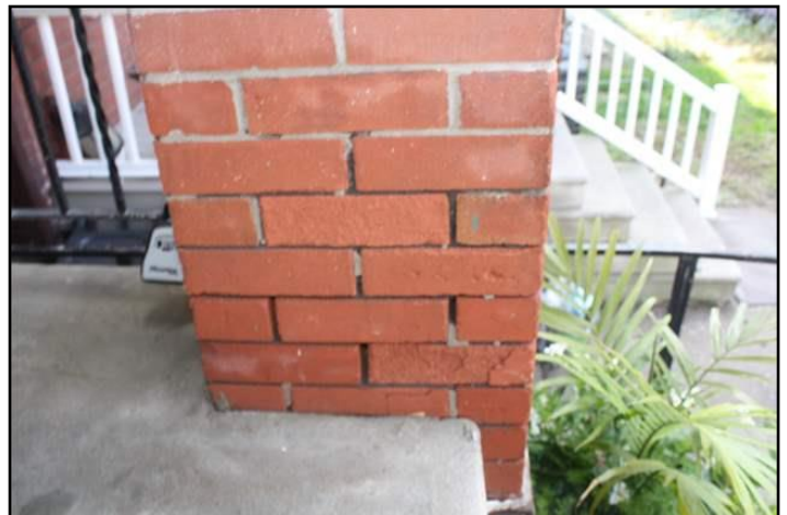
13. Spalling
