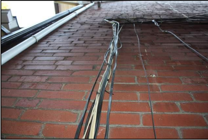
10. Flexible conduit needed
