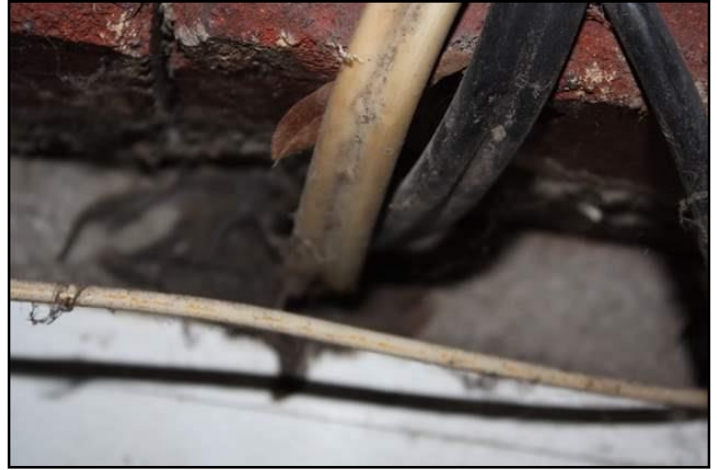
11. Flexible conduit needed
