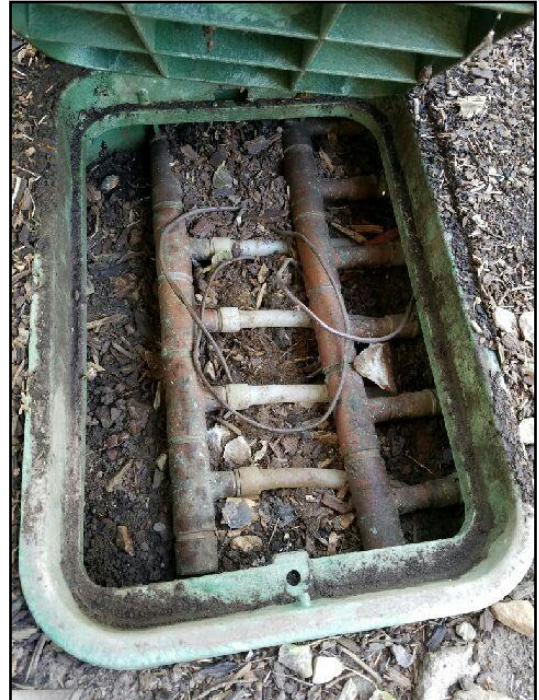
Radiant heat tubing
