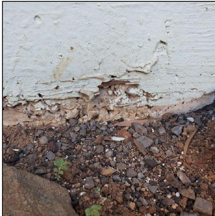
Spalling
