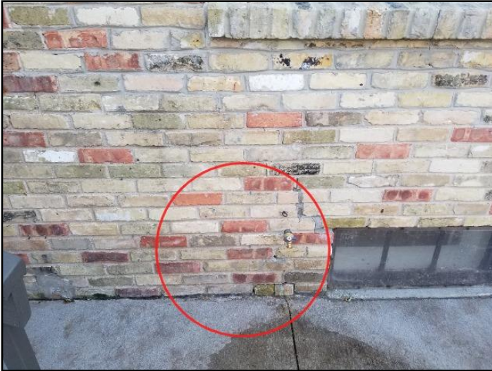
34. Mortar deterioration
