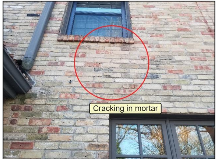
35. Mortar deterioration
