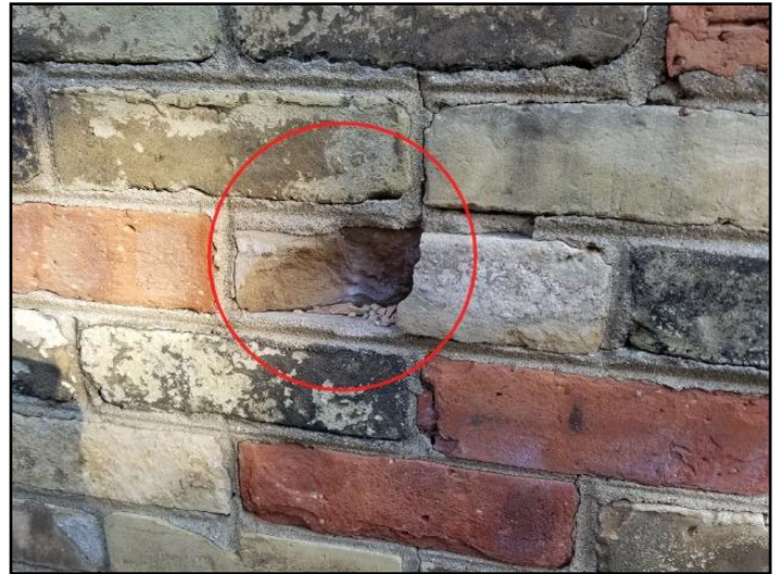
31. Spalling
