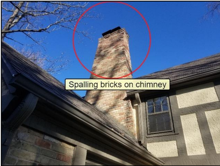
30. Spalling
