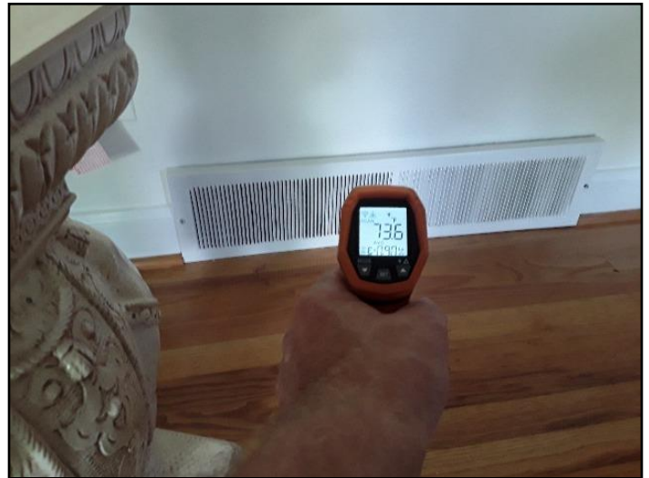
28. Cooling return temp 74 deg
