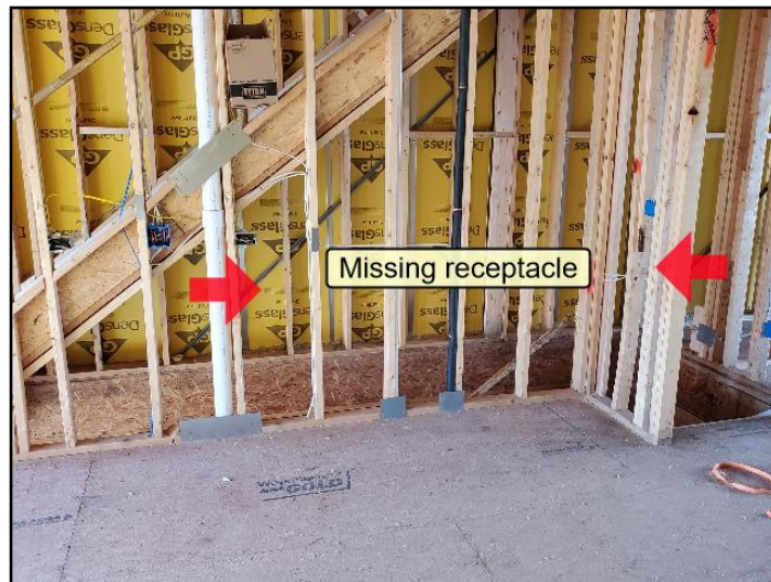
Receptacle Spacing
