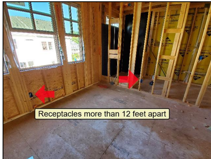
Receptacle Spacing
