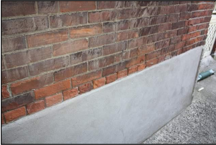
14. Spalling
