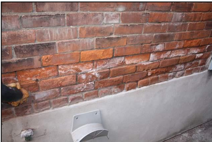
12. Spalling
