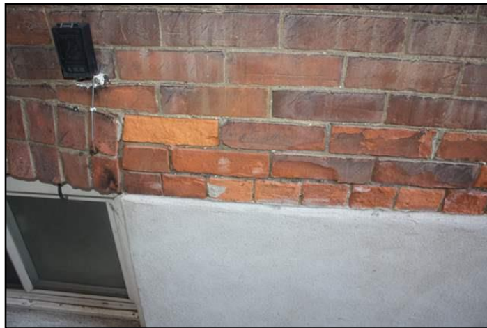
16. Spalling
