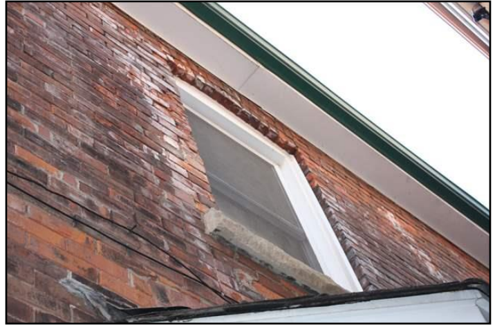
15. Spalling
