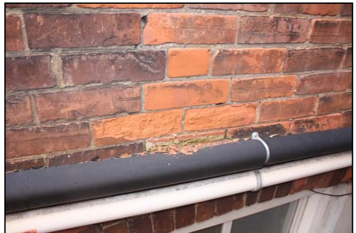
13. Spalling
