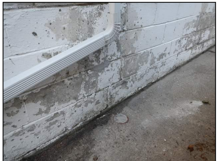
Spalling
