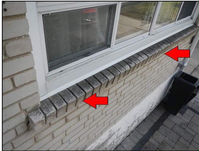
Spalling
