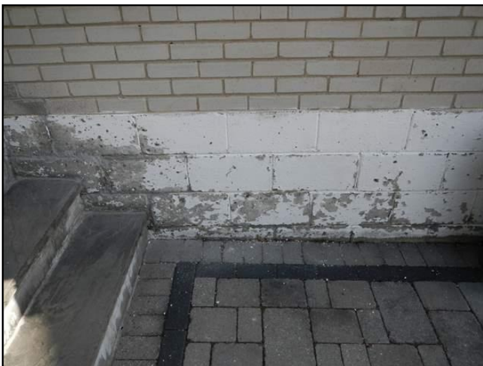
Spalling
