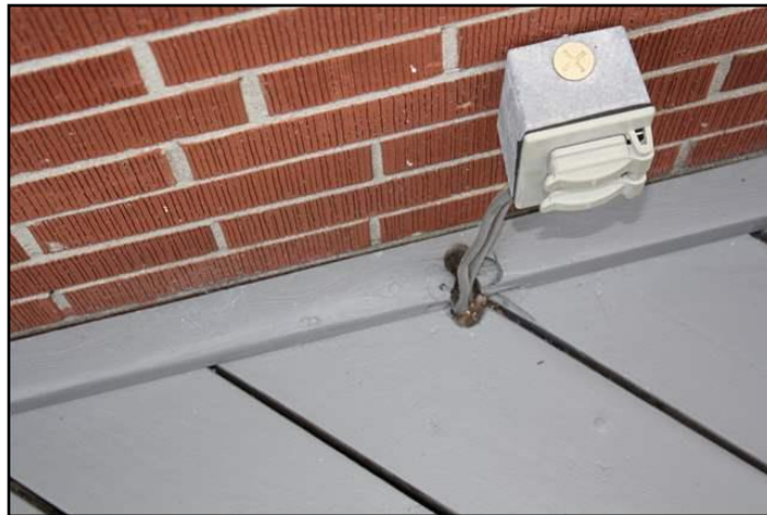
17. Flexible conduit needed
