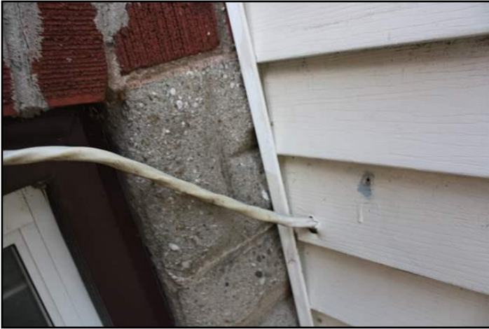
15. Flexible conduit needed
