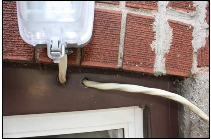
16. Flexible conduit needed
