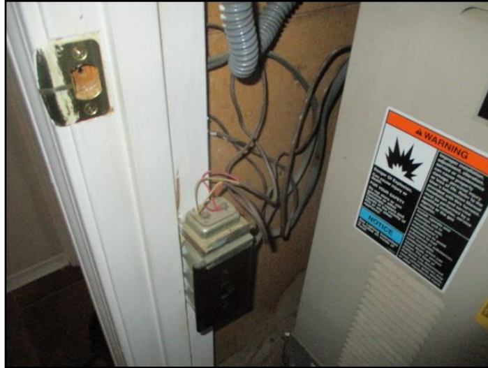
21. Flexible conduit needed
