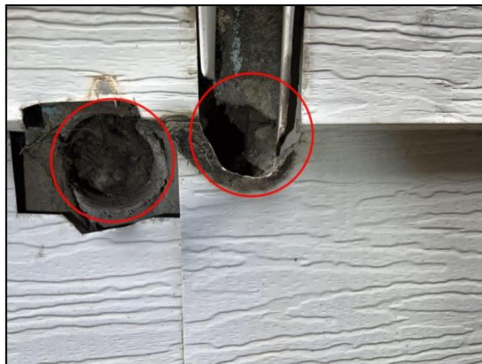
Patch/seal conduit
