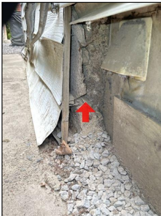
Spalling
